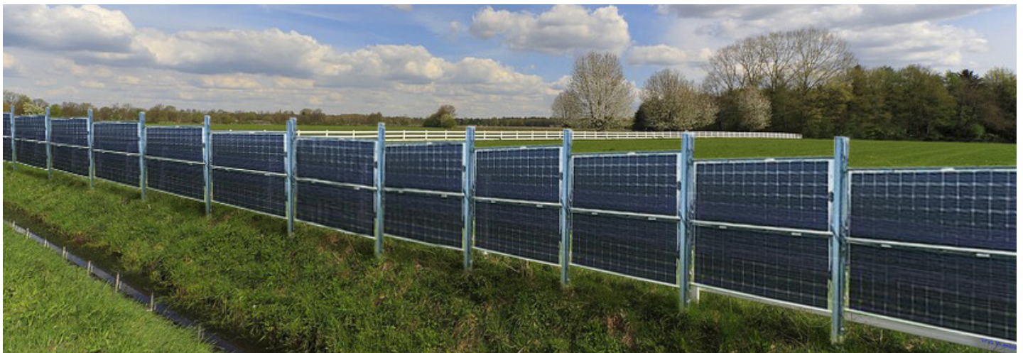
AgriPV Zaun, doppelreihig, horizontale Montage
