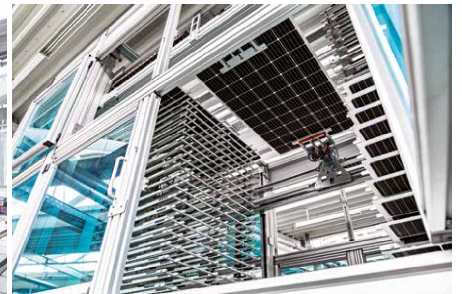
Abkühlturm nach den Laminatoren (Abkühlprozess von 140 auf 25°C) Cooling tower after the laminators (cooling process from 140 to 25°C)
